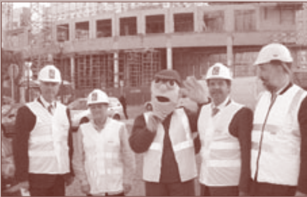
Auf der Baustelle, ...
