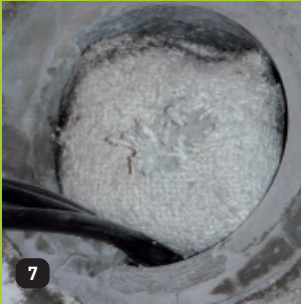
Loose asbestos lagging
